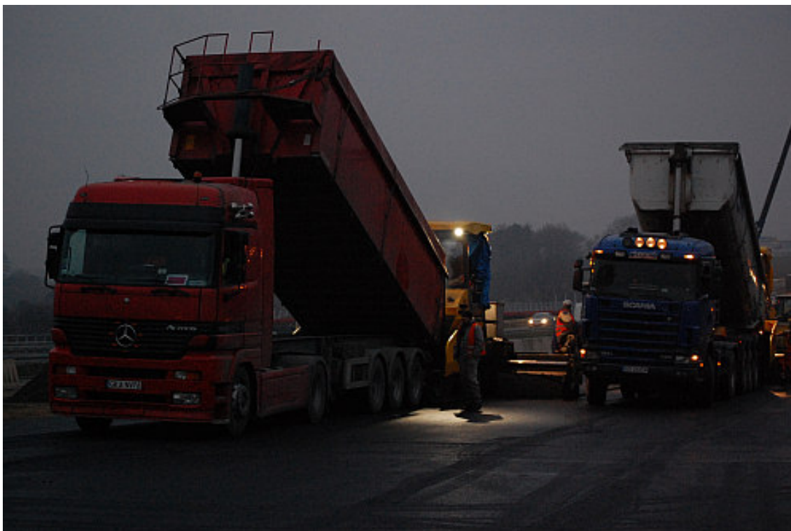
Fot. 6 – Rozkładanie mieszanki SMA wyprodukowanej ze środkiem ViaTop Plus CT 40 równocześnie przez dwie rozkładarki
