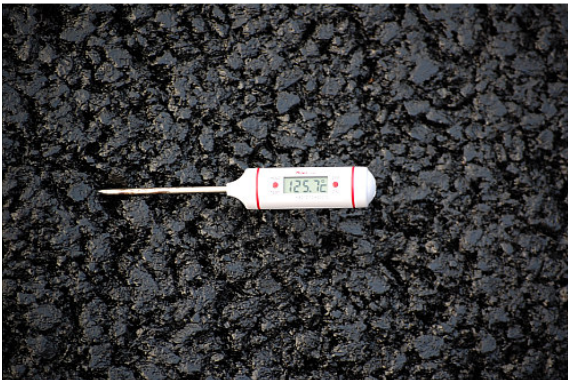
Fot. 5 – Jeden z pomiarów temperatury mieszanki w trakcie układania
