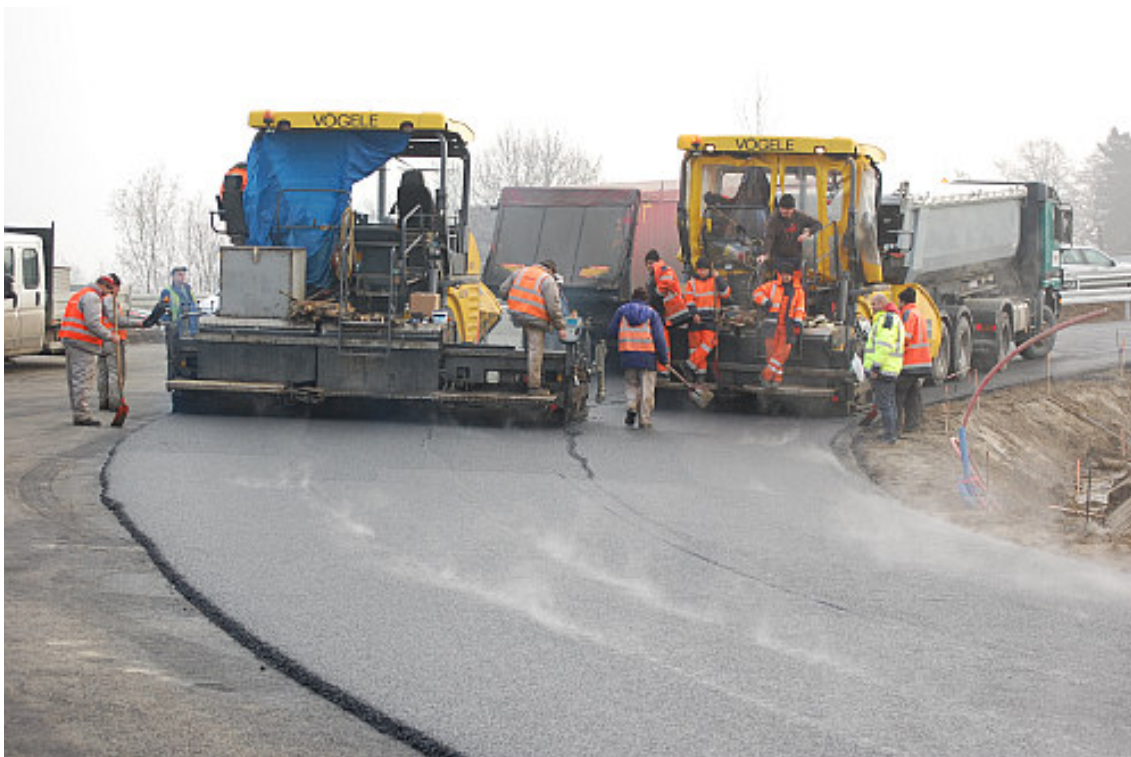
Fot. 3 – Rozkładanie mieszanki SMA wyprodukowanej ze środkiem Ceca Base RT równocześnie przez dwie rozkładarki
